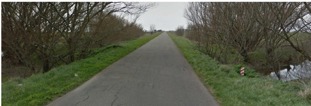
Imagen 02: Puente sobre Arroyo Quinhual (Km 51,53).
