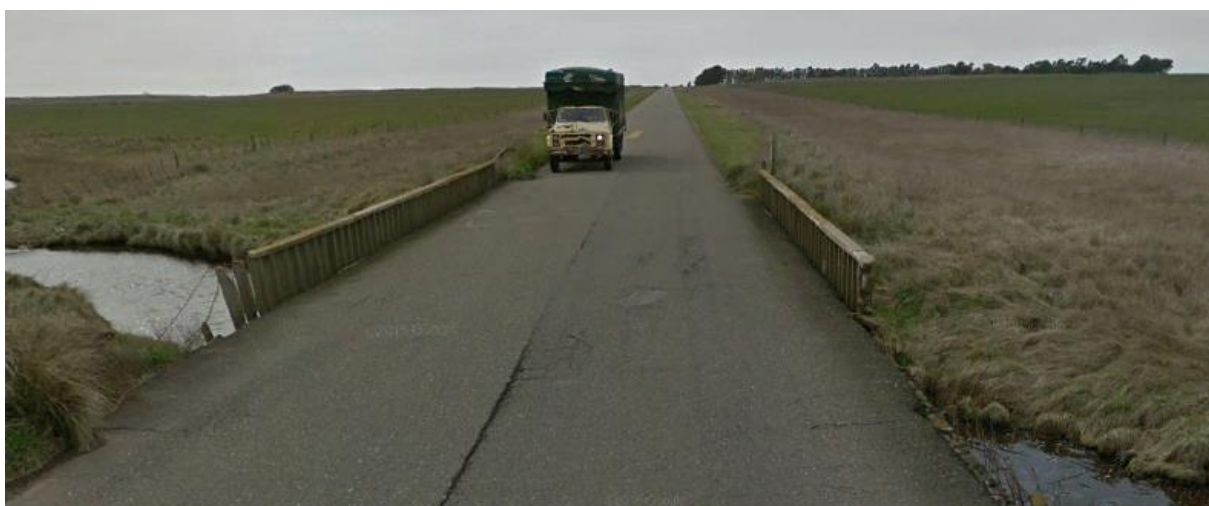
Imagen 03: Puente sobre Arroyo Catriel (Km 51,175).
